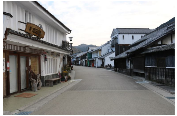
無電柱化されたまち並み
