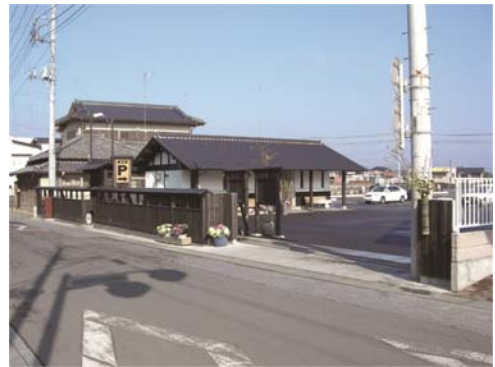
▲景観に配慮したトイレ・駐車場整備
