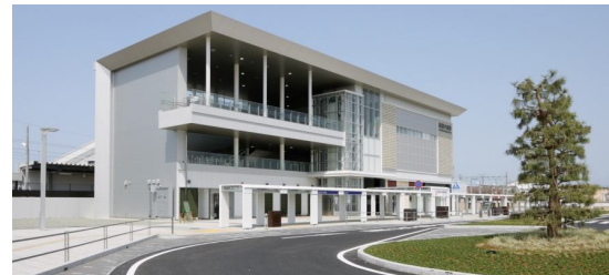
▲ 駅舎と駅前広場及びシェルター（東口側）
