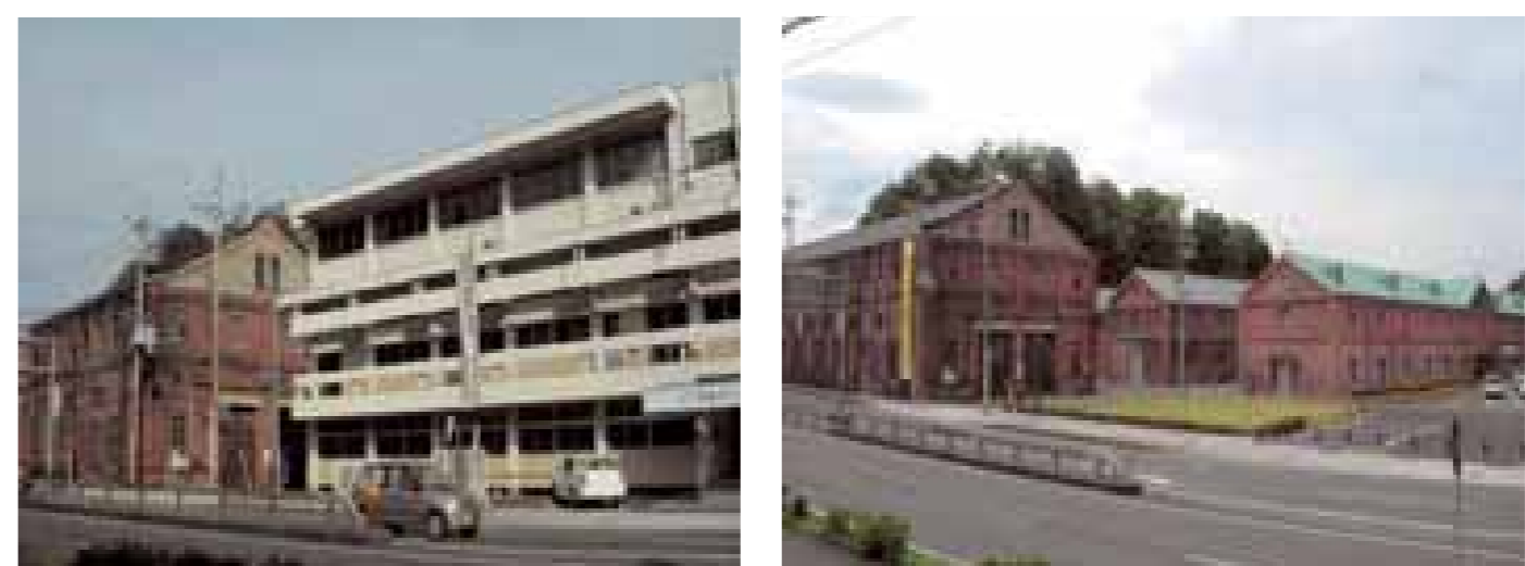
▲倉庫群の景観の妨げとなっていた建物を除去
