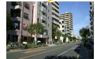
沿道建築物の不燃化
