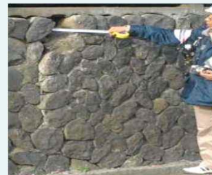
擁壁の危険度調査
