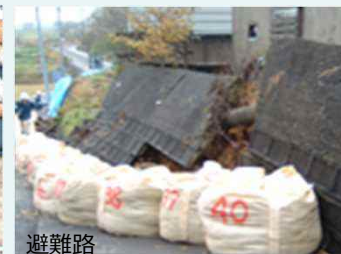
擁壁の防災対策
