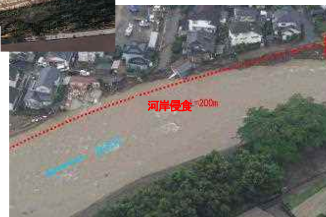
河岸侵食に伴う家屋倒壊等
