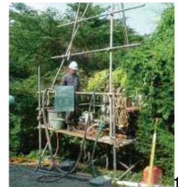
ボーリング調査
