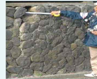
擁壁の危険度調査
