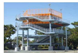
津波避難タワー
