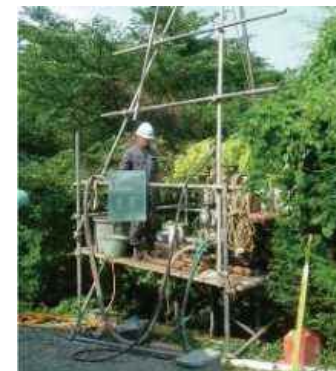
ボーリング調査
