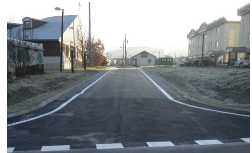
▲狹隘道路改良
